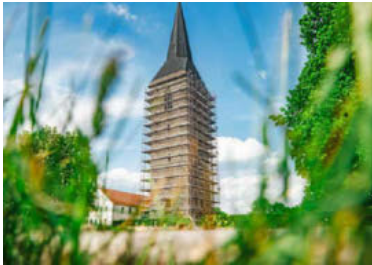
Ein Gerüst umgibt den 62 Meter hohen Petriturm in Nordhausen.
