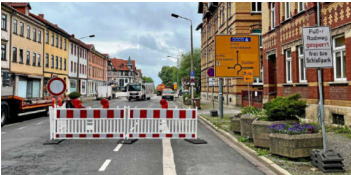
Der Straßburgkreisel in Arnstadt ist seit Montag, 5. Mai, gesperrt und wird saniert.
