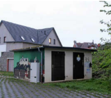
Am Trafo-Häuschen auf dem Parkplatz unterhalb der Raniser Burg soll eine E-Ladesäule aufgestellt werden.
