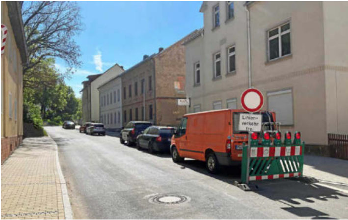
Blick auf den ersten Teil des 2. Bauabschnittes in der Salzstraße in Liebschwitz. TINA PUFF
