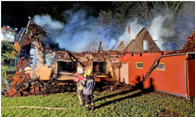
Die Flammen wüteten so massiv, dass das Gebäude nicht mehr zu retten war.
